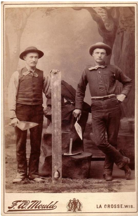
ZUSAMMENFASSUNG: Um die Verjüngung des Schornsteins während des Baues zu kontrollieren, benutzten die Schornsteinbauer ein **selbst hergestelltes Richtscheit** (Lehre), **an das eine Wasserwaage** seitlich oder (besser ablesbar) oben **angeschraubt war**. Früher benutzte man nur ein Richtscheit mit einem Senklot (hat große Nachteile bei Wind)
